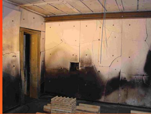
Brandraum mit Stahlträger 3 und Brandraumtür
