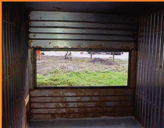
Ventilationsöffnung
