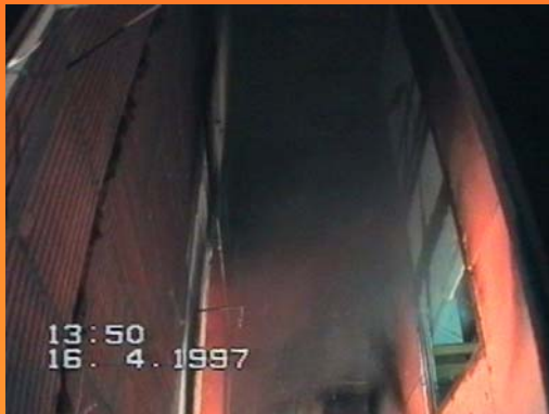
2 min 54 s Fensteröffnung Flashover
