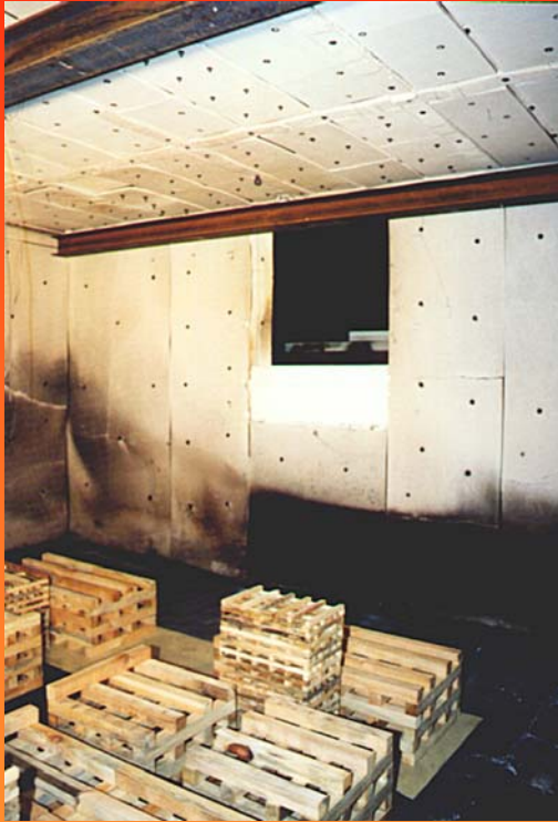
Brandraum mit Stahlträger 1, 2 und Fensteröffnung
